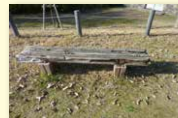
劣化した ベンチの状態
